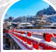
สะพานนากะบาชิ
