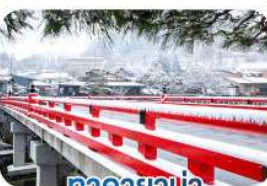
คาคายาม่า สะพานนากะบาชิ
