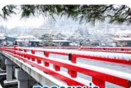
คาคายาบา สะพานนากะบาชิ
