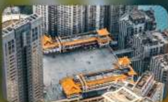
อาคารชุด 22 ชั้น
