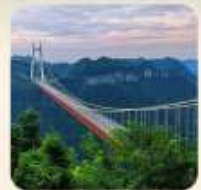
สะพานอ้ายจ้าย
