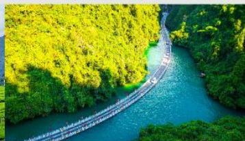
สะพานลอยน้ำสือจื่อทวน
