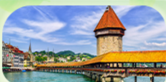
สะพานไมซ์าเปค
