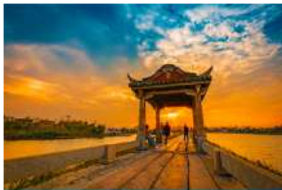
สะพานอันผิง
