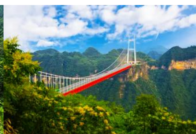
สะพาน ไร่ย้งถ้ำเจียว
