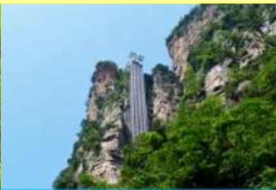
ลิฟท์แก้วไปหลม
