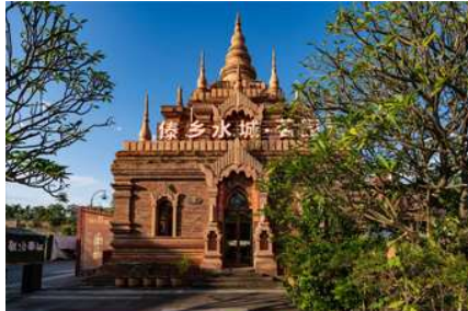
เมืองน้ำเทีลื้อ
