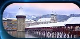
สะพานไม้ชาเปล
