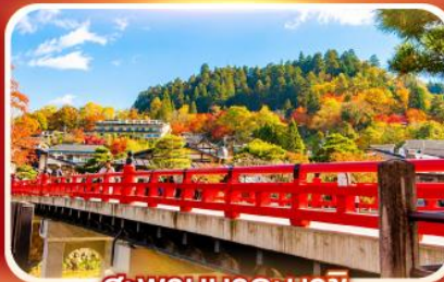
สะพานนากะบาชิ
