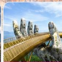
สะพานมือสีทอง
