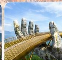
สะพานมือสีทอง
