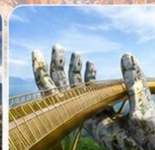
สะพานมือสีทอง
