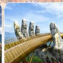
สะพานมือสีทอง
