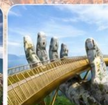
สะพานมือสีทอง
