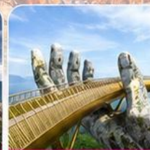
สะพานมือสีทอง
