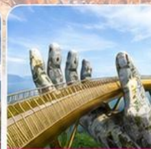
สะพานมือสีทอง
