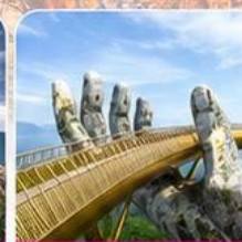
สะพานมือสีทอง
