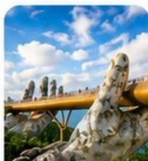
สะพานมือสีทอง
