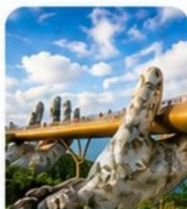
สะพานมือสีทอง
