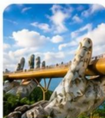
สะพานมือสีทอง
