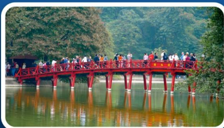
สะพานแสงอาทิตย์
