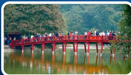
สะพานแสงอาทิตย์
