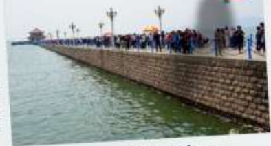
สะพานฉานเฉียว
